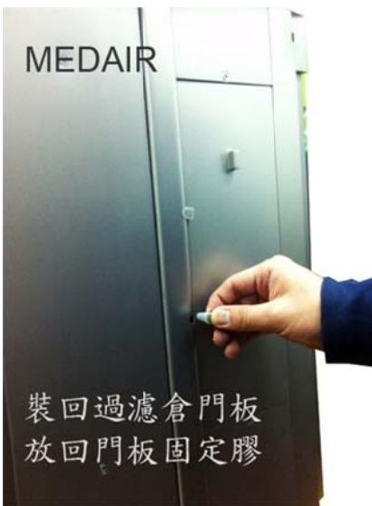
安装门板，先装上安装橡皮塞
